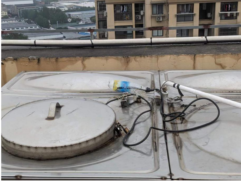
图4 水箱上方的检修口和塑料瓶
