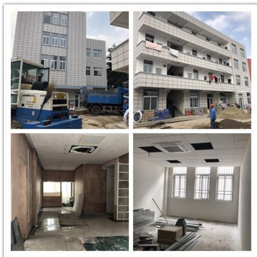
附件 6-2、2018 年 10 月底施工图片
